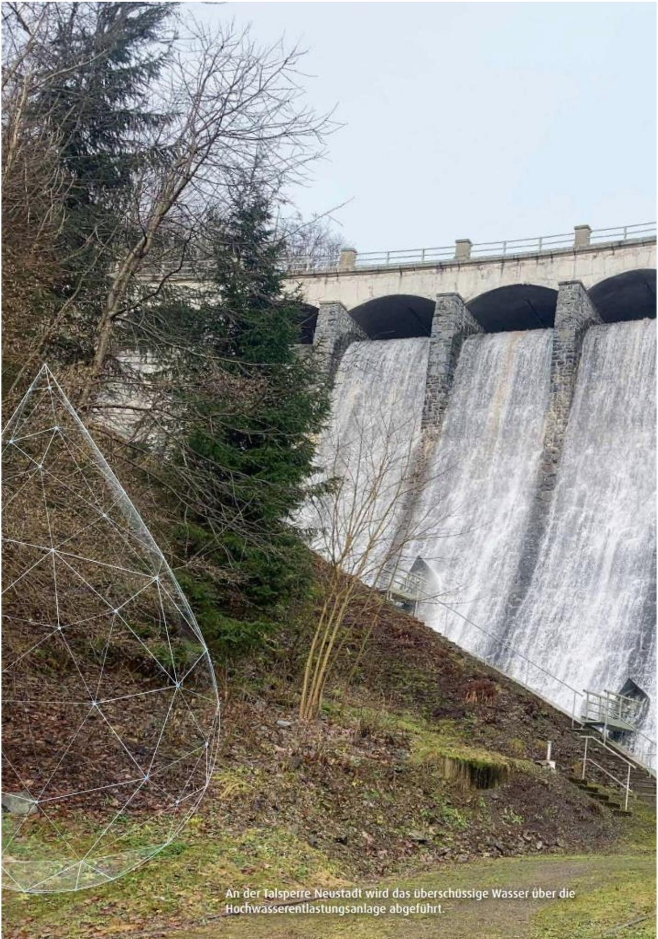
An der Talsperre Neustadt wird das überschüssige Wasser über die Hochwässerentlastungsanlage abgeführt.
