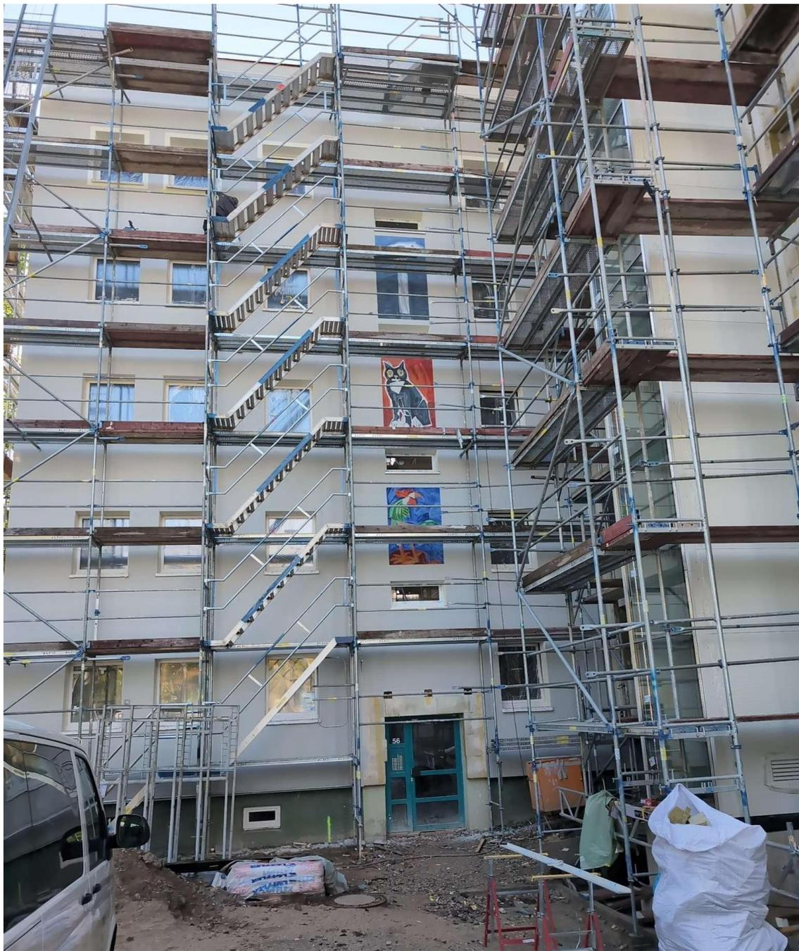
Aktuelles Bauprojekt Sanierung Laasener Str. 52-56, 07546 Gera; Sanierungsgebiet „Ostviertel/Südl. Innenstadt“; Vollsanierung Plattenbau WBS70 inkl. Aufzugsanbau bzw. -einbau, Wärmedämmung, 3-fach-verglaste Fenster, Grundrissänderungen, Erneuerung der gesamten Gebäudeinstallation, Aufwertung der Außenanlagen (inkl. Fahrradgarage, Mietergärten, Aufenthaltsbereiche); Fassadengestaltung mit 4 Bildern des Geraer Künstlers Eberhard Dietzsch; Investitionskosten ca. 4 Mio. €
