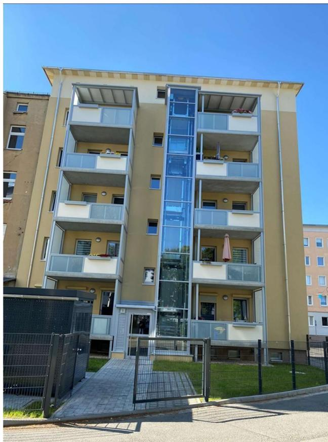
Sanierung Wohngebäude Schülerstr. 1, 07545 Gera (Vollsanierung inkl. Wärmedämmung, 3-fach Verglasung, Balkon- und Aufzugsanbau)
